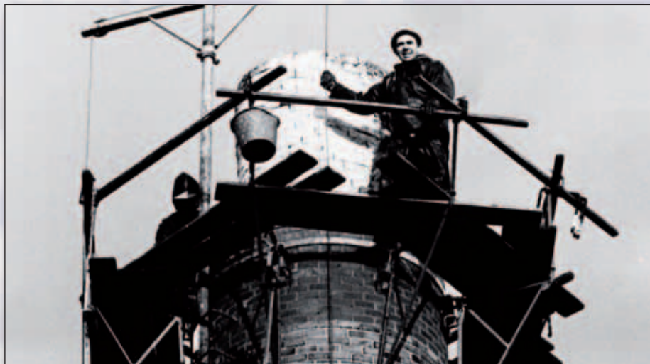
Skorstenen under opførelse. 1958.
