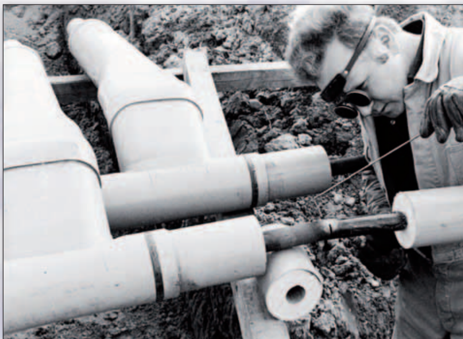
Kaj Andersen svejser rør
